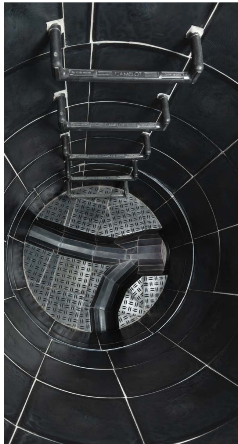
Vnitřní obklad spadiškové šachty čedičem
