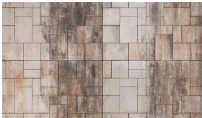
CHYBNĚ plocha vytvořená položením jedné vrstvy tak, jak je uložena na paletě
