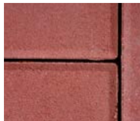
CHYBNĚ pokládka kamenů na sraz a vyštípání hran jako důsledek nesprávné šířky spár nebo nedostatečného zapískování
