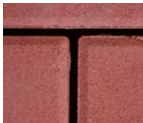
SPRÁVNĚ (PŘED ZAPÍSKOVÁNÍM) dodržena spára 3–5 mm
