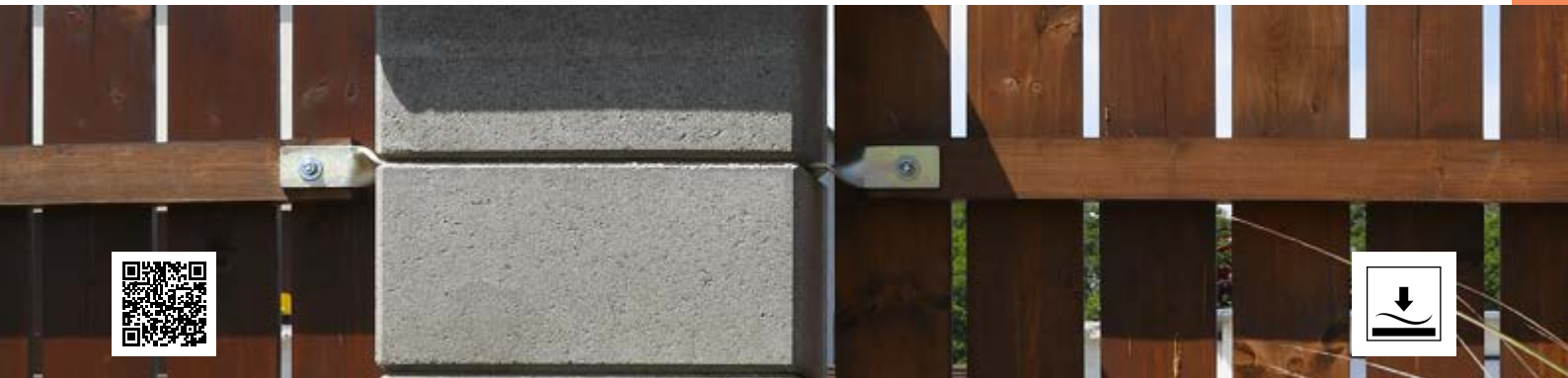
úchyt plotové výplně I (pozn.: při realizaci otočit úchyt o 90°)
