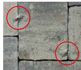
CHYBNĚ pokládka kamenů na sraz a vyštípání hran jako důsledek nesprávné šířky spár nebo nedostatečného zapískování
